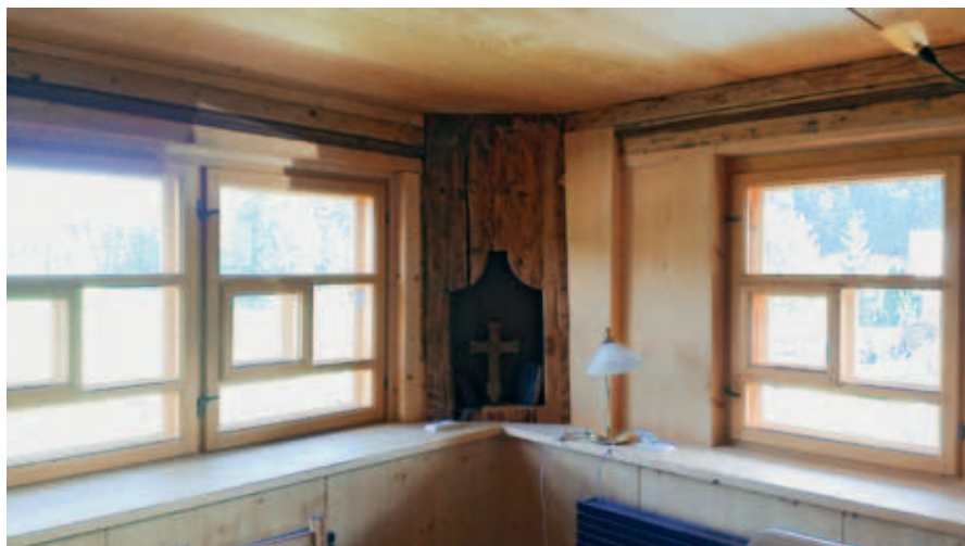
Innenansicht der Stube, die die wesentlichen Elemente einer Schwarzwälder Stube aufweist mit ergänzter, stark reduzierter hölzerner Raumschale
