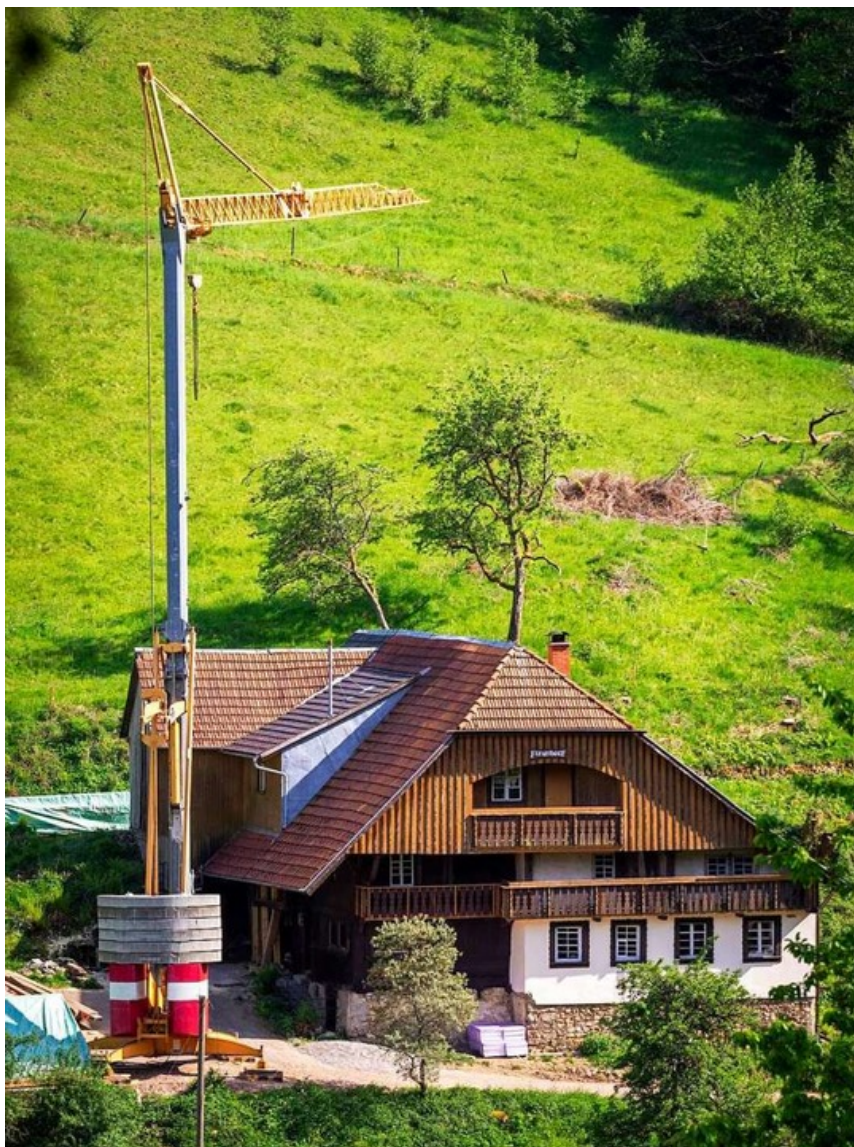
Das alte Tagelöhnerhaus am Farnrain wird restauriert. So sah es vor Beginn der Arbeiten aus. Foto: Patrick Kunkel
